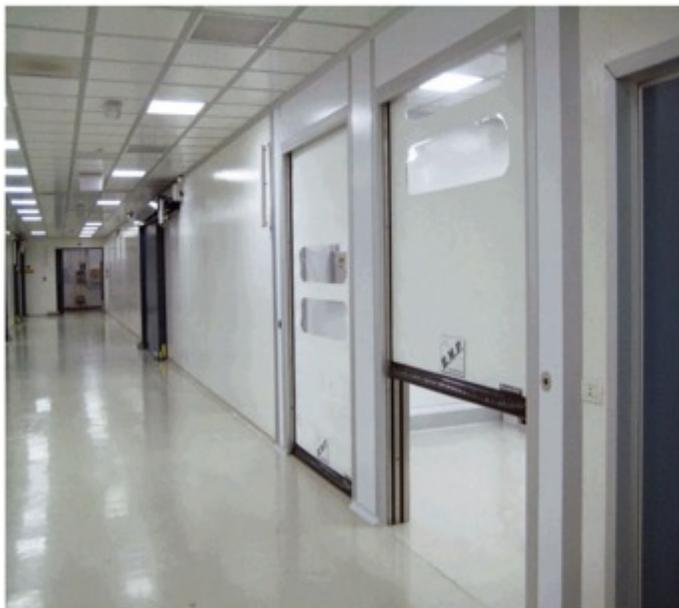
Sistema Interlock con apertura automática
