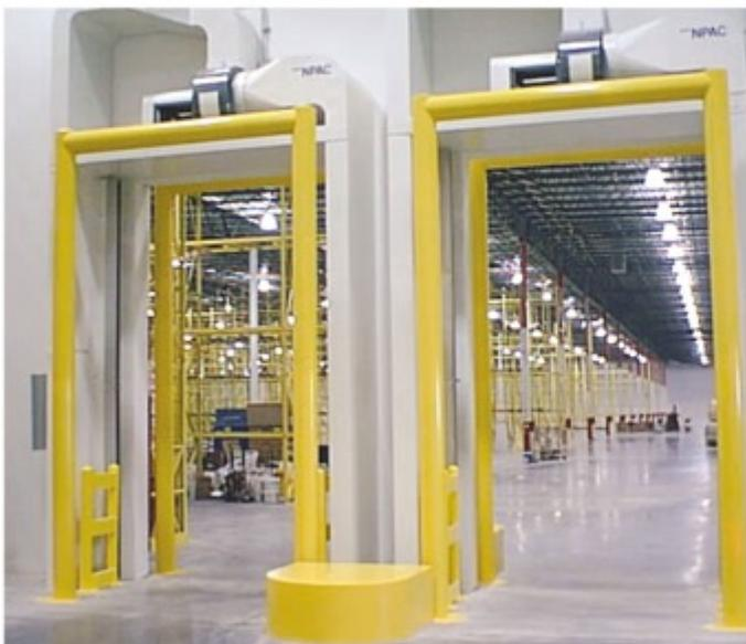
El modelo básico NPAC está hecho para contrarestar el flujo unidireccional causado por la presión negativa o por efecto del viento.
